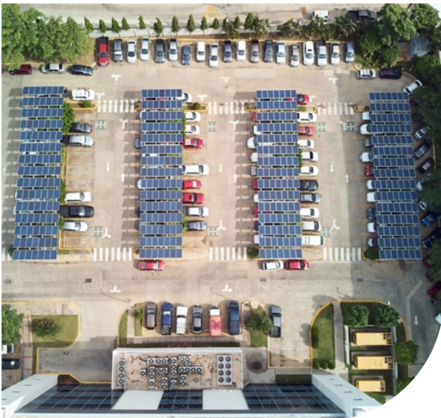
Eine Kombination aus Parkplatz-Photovoltaik und Ladeinfrastruktur/Batteriespeicher ermöglicht die direkte Nutzung von Solarstrom vor Ort für die Elektromobilität
