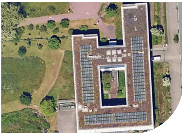
Ansicht der installierten PV-Anlagen auf den zuvor über das LANUK-Solarkataster analysierten Gebäude-dächern (google-maps)
