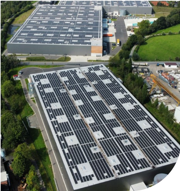
Die Stadtwerke Wülfrath ließen auf den gepachteten Dächern eines Logistikzentrums eine große PV-Anlage installieren. [8]
